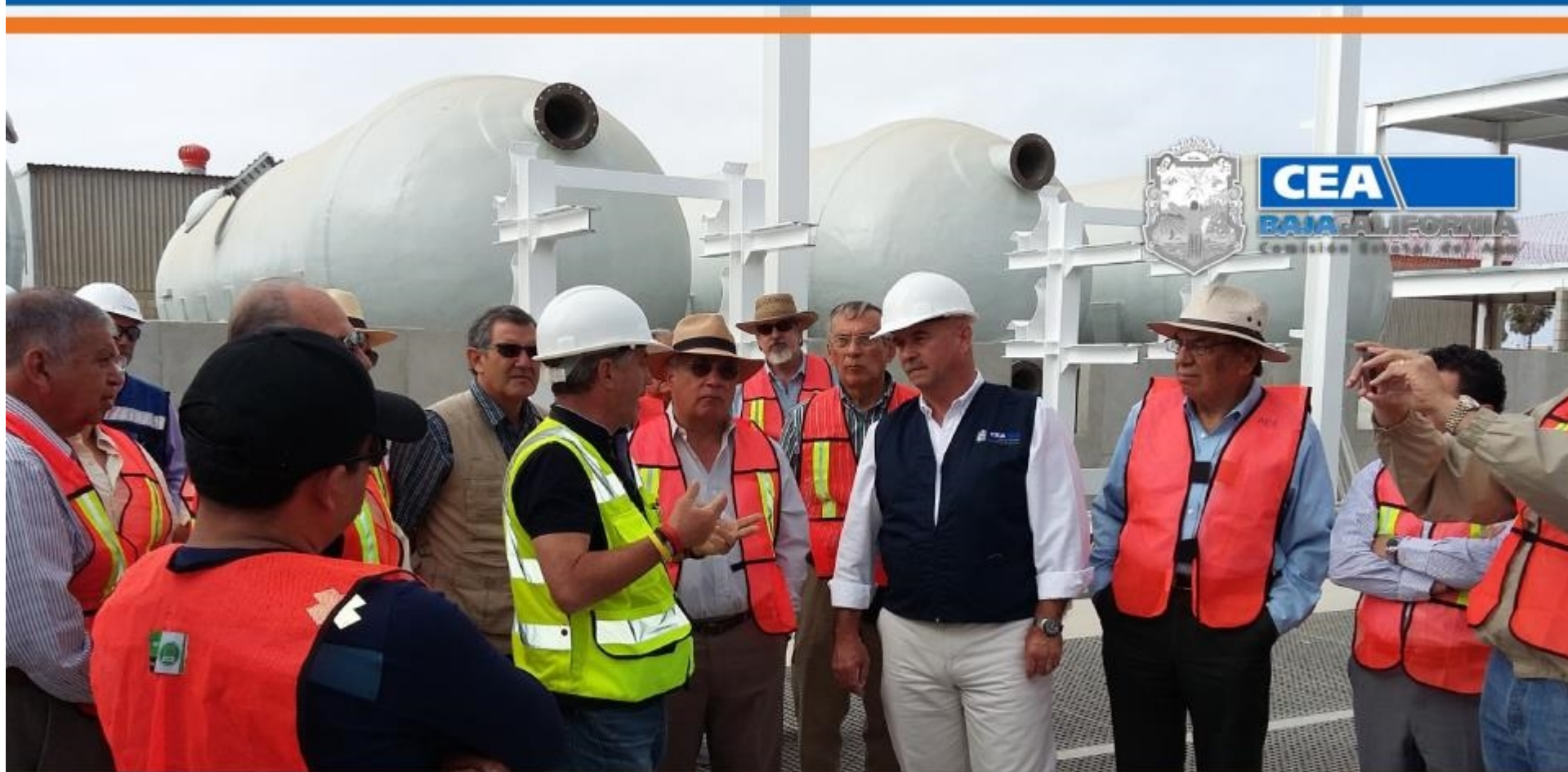
Arq. Germán Jesús Lizola Márquez en compañía del Grupo Madrugadores de Ensenada en visita a los avances de la Construcción de Planta Desaladora en Ensenada
